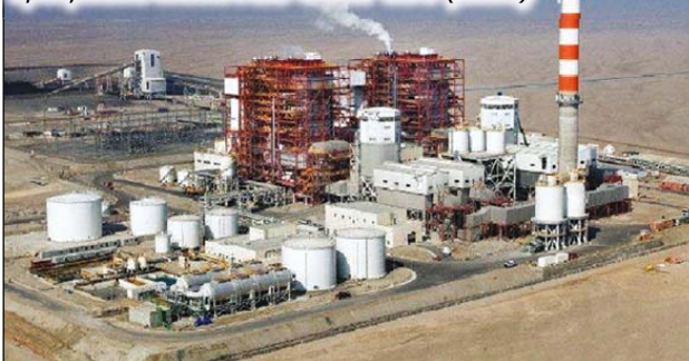
Vedere panoramică a termocentralei Angamos, aparținând firmei AES Gener S.A. (Chile)
