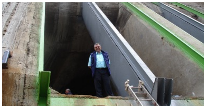
(Foto: Reabilitare priză de apă baraj Vidra-lac gol, 2009).
