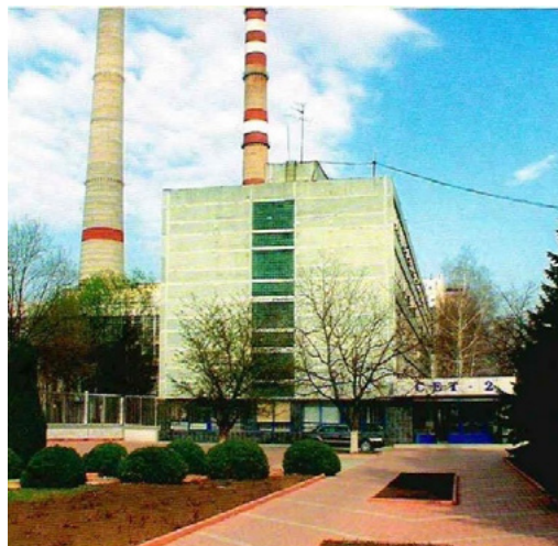
Foto: vedere CET-2
