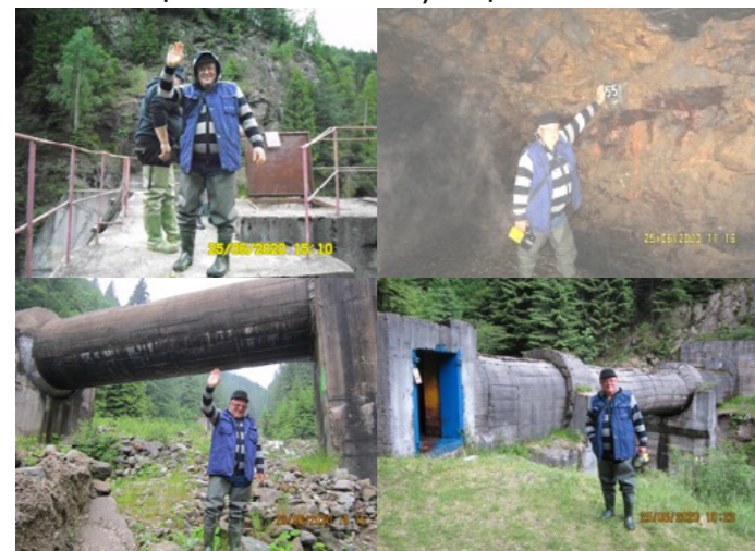
Foto: Controlul rețelei de captări și aducțiuni (galerii) secundare din Amenajarea Lotru (iunie 2020)
