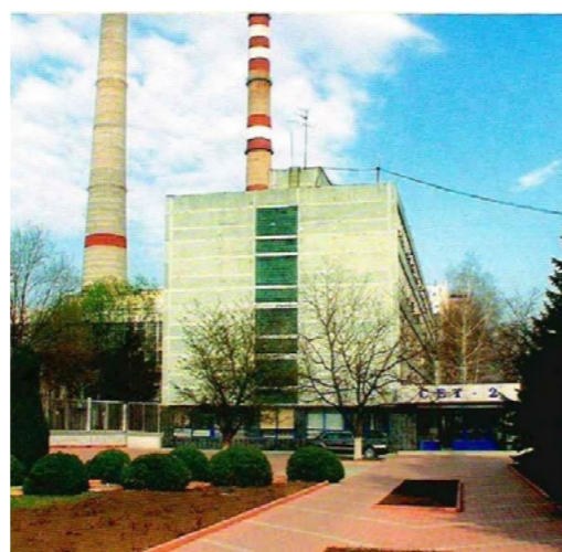
Foto: vedere CET-2
